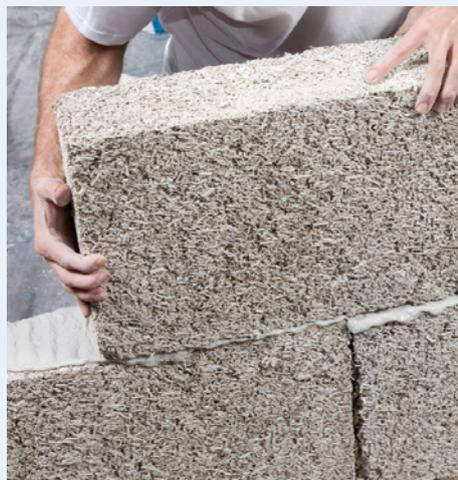
**Uso:** la cal aérea se mezcla con cañamo triturado para crear ladrillos o forjar paredes, que se endurecen mediante carbonatación
